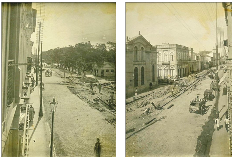
Figuras 14 e 15 – Adequação das linhas de tração animal para elétrica.
