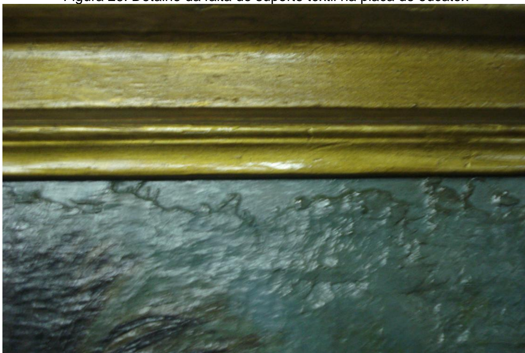
Figura 26: Detalhe da falta do suporte têxtil na placa de eucatex
